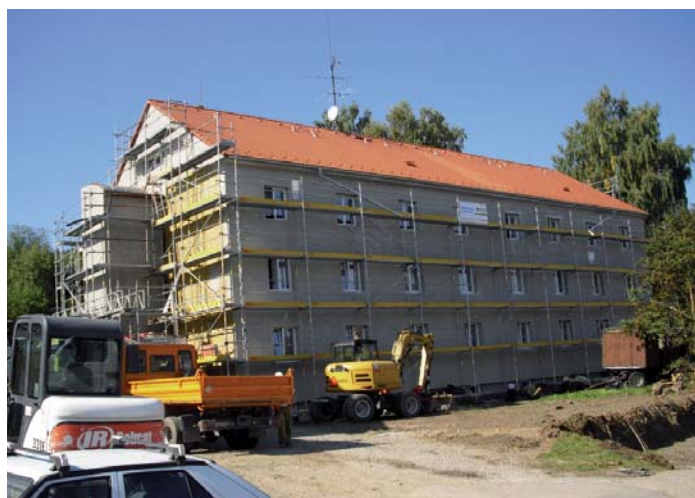
Zateplení a výměna oken v ulici Na Žofíně č.p. 214
