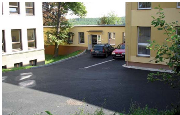
Nově rekonstruovaná přístupová komunikace k pavilonu školní družiny
