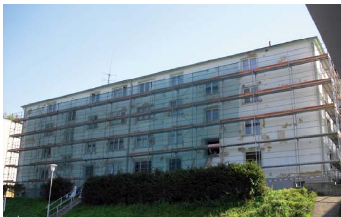
Zateplení a výměna oken obecních bytových domů ve Školní ulici č.p. 235, 236, 237
