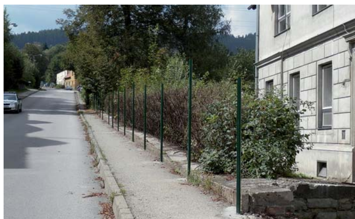
Oprava plotu u domu čp. 59-60 v ul. Šumavská
