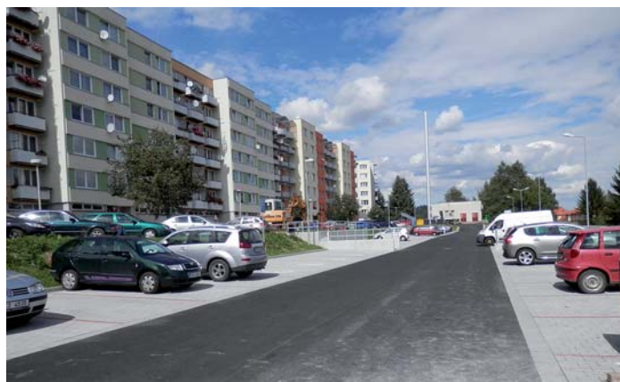
Výstavba parkoviště v ulici Sadová - 80 parkovacích míst
