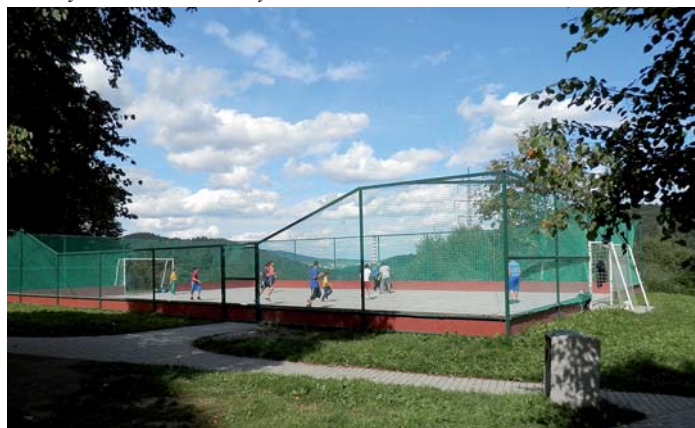
Výstavba dětského hřiště sídliště Urbal - v rámci II. etapy revitalizace sídliště Urbal
