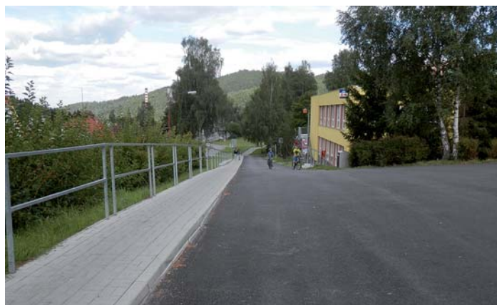
Oprava komunikace kolem domu čp. 1 k prodejně COOP Jednota, ul. Šumavská
