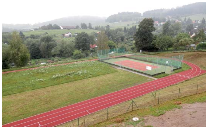
Výstavba multifunkčního hřiště v areálu ZŠ + atletické zařízení
