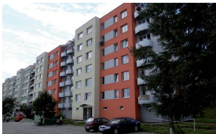
čp. 297, 298 a 299 ul. Sadová - zateplení a výměna oken a vchodových dveří
