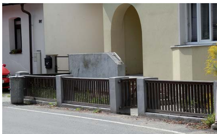
Oprava podezdívky a plotů u domů čp. 96-109 ul. Na Žofíně
