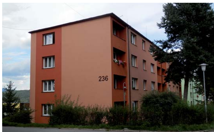
čp. 235, 236 a 237 ul. Školní - zateplení a výměna oken a vchodových dveří
