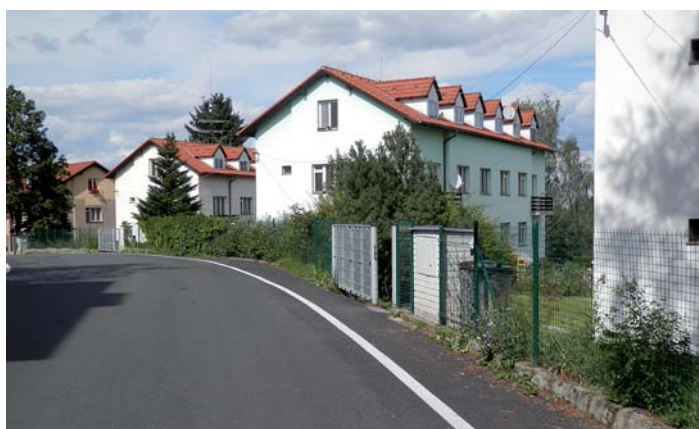
Oprava plotu v ul. Na Žofíně u domů čp. 205-209
