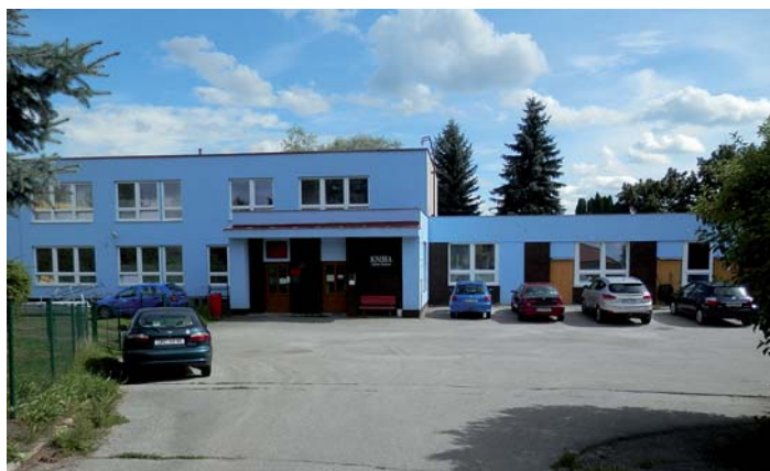
čp. 296 ul. Školní - výměna oken, rekonstrukce vnitřního uspořádání - zasedací místnost ZO, knihovna, spisovna
