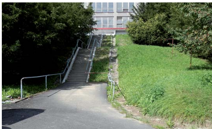
Oprava schodů a přístupové komunikace k domu čp. 238
