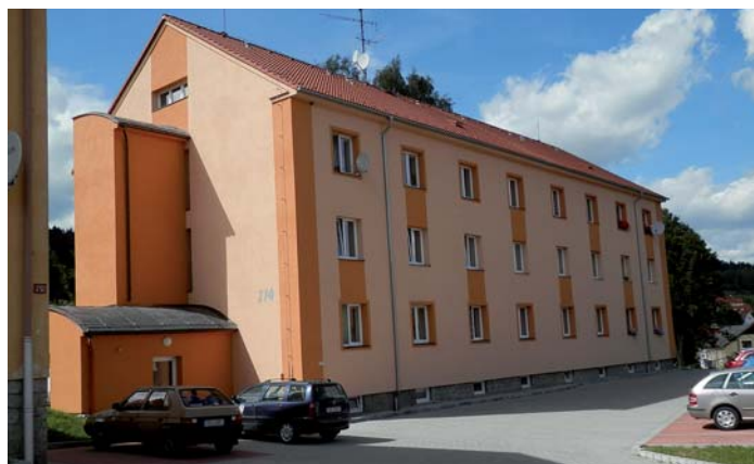
čp. 214 ul. Na Žofíně - zateplení a výměna oken
