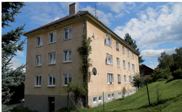
čp. 233 ul. Souběžná - výměna oken a zateplení stropu
