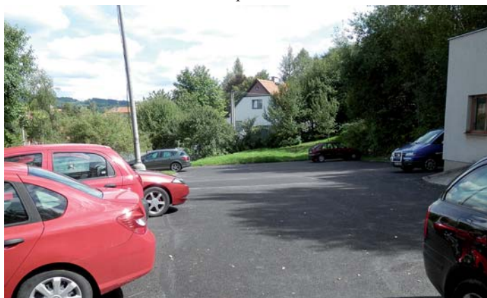
Oprava povrchu parkoviště pod čp. 304 v ul. Sadová
