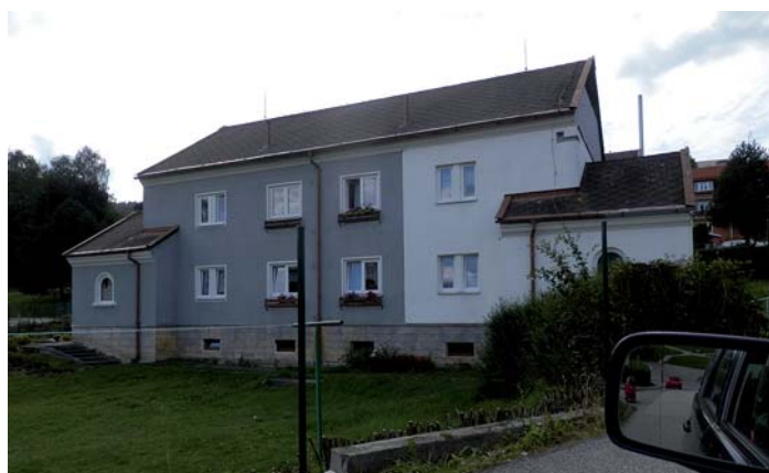
čp. 214-227 ul. U Kapliček - výměna oken a vchodových dveří
