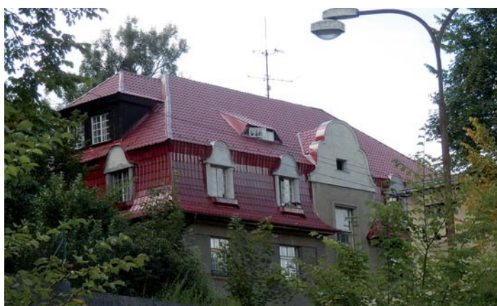
čp. 101 ul. Šumavská - rekonstrukce střechy
