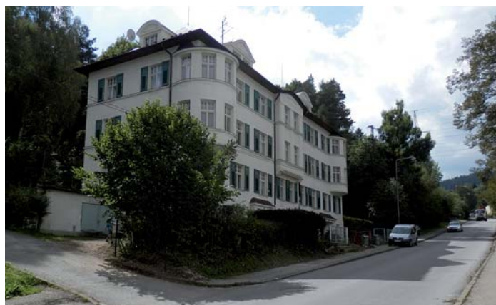
Oprava a nátěr oken čp. 72 a 73 ul. Šumavská
