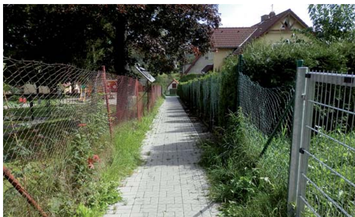
Výstavba chodníku mezi ulicí Školní a Zahradní
