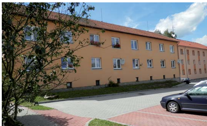
čp. 212 ul. Na Žofíně - výměna oken
