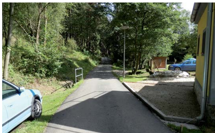
Oprava komunikace do Dolního Němče
