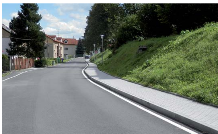
Výstavba chodníku v ul. Na Žofíně a Pod Topoly
