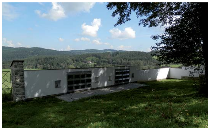
Oprava hřbitovní zdi s výstavbou kolumbárií
