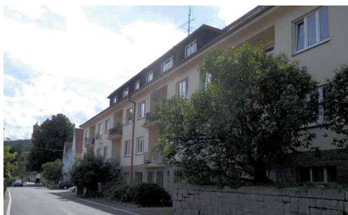
čp. 199-200 ul. Na Žofině - výměna oken a vchodových dveří
