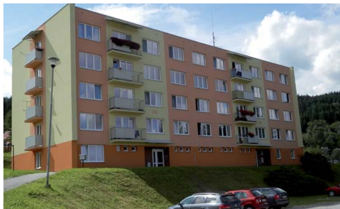
čp. 239-240 ul. Souběžná - zateplení a výměna oken
