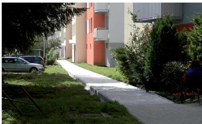
Oprava chodníku v ulici Sadová před domy čp. 297-304
