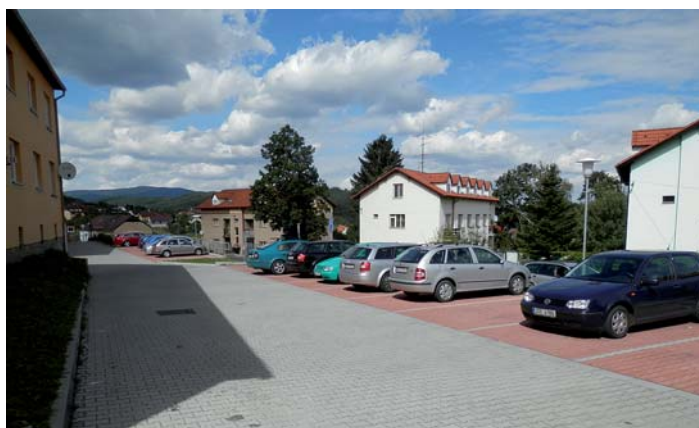
Výstavba parkoviště u čp. 212-214, ul. Na Žofině
