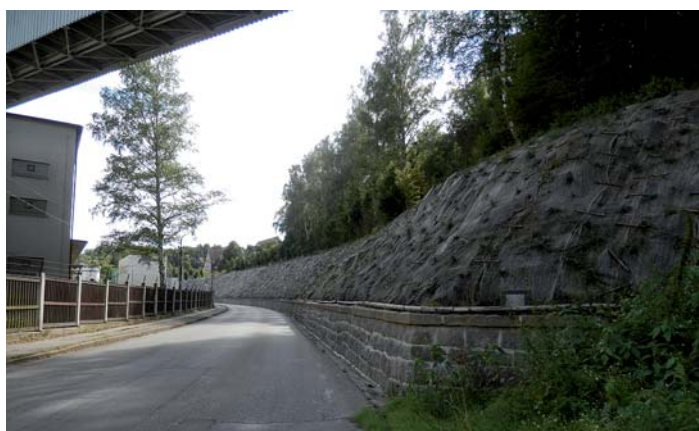
Oprava opěrné zdi v ulici Papírenská a úprava svahu nad ní
