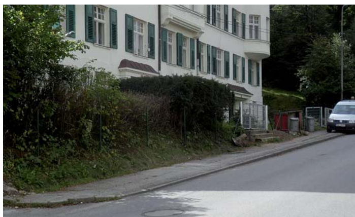
Oprava plotu u domu čp. 72-73 v ul. Šumavská
