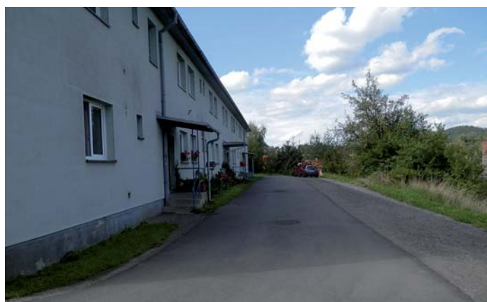
Oprava komunikace na Armabetonu kolem domů čp. 197 a 230
