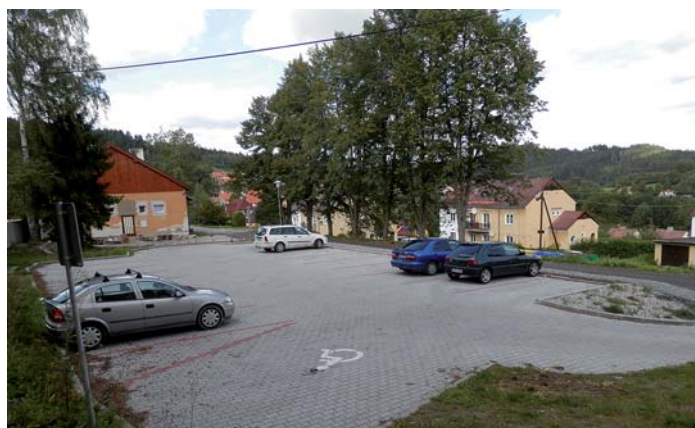
Zbourání čp. 211 v ul. Souběžná a vybudování nového parkoviště
